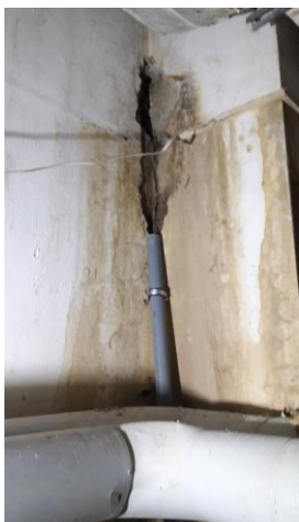
Fot. 1. ubytek w ścianie
