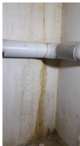
Fot. 2. Zawilgocone rysy w ścianie
