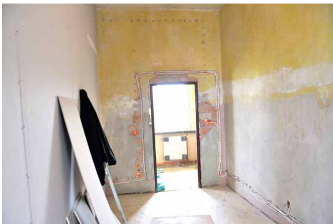
Prace adaptacyjno-remontowe w budynkach byłego Gimnazjum nr 2
