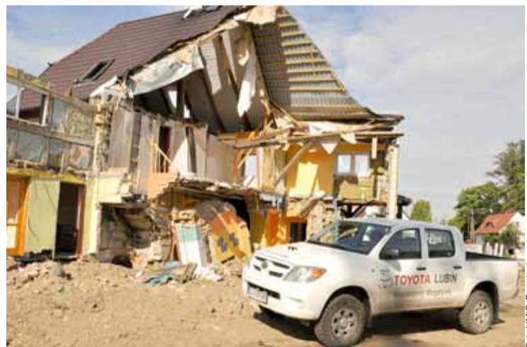
Jeden z wielu zniszczonych domów.
