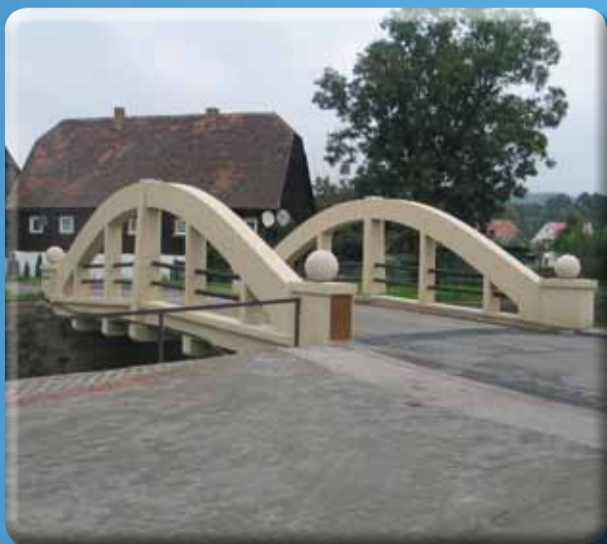
Most drogowy przy ulicy Turowskiej.
