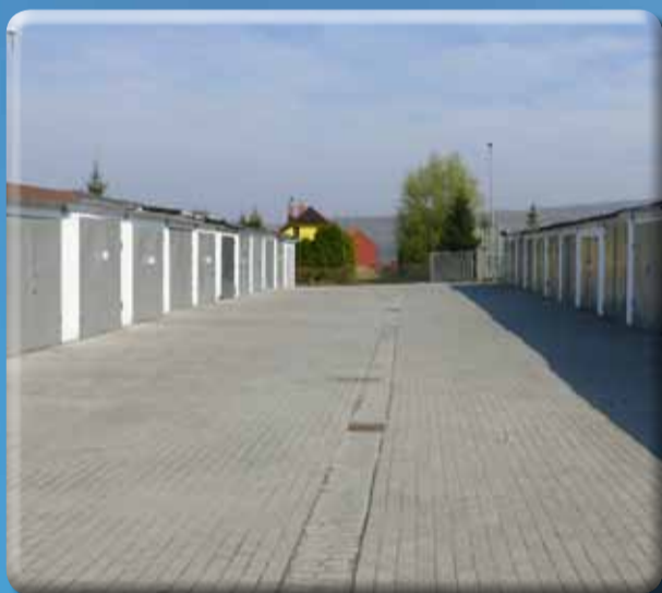
Nowa nawierzchnia przy garażach na ulicy Szpitalnej.
