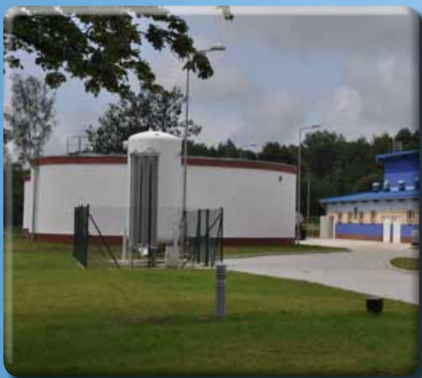
Stacja Uzdatniania Wody – jedna z trzech najnowocześniejszych stacji w Polsce.
