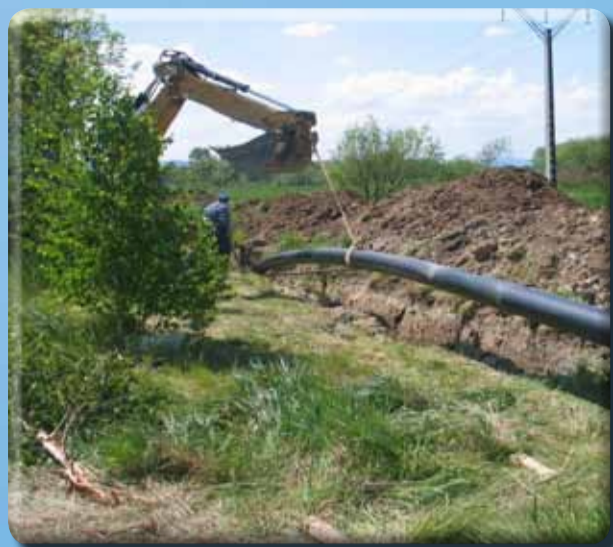
Magistrala Przesyłowa Wody Zimnej Zatonie- Sieniawka.
