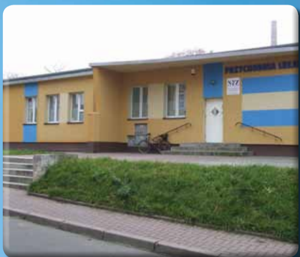
Odremontowana przychodnia SP ZOZ-u przy ulicy Fabrycznej.
