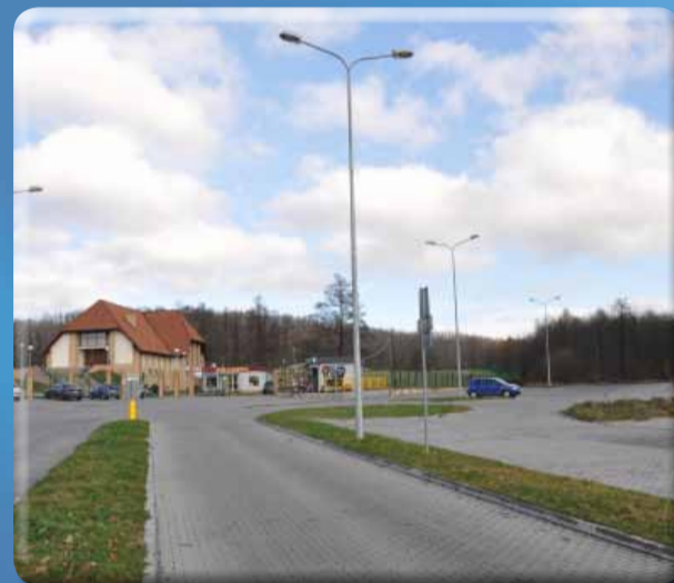
Zmodernizowany plac parkingowy przy cmentarzu w Bogatyni.
