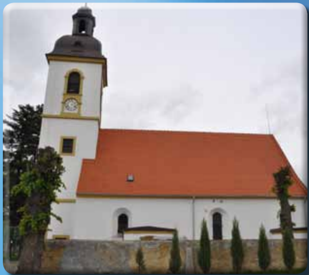
Nowy dach kościoła w Sieniawce.
