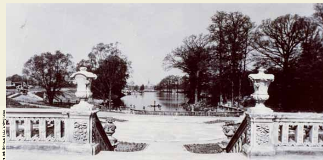
Fot. Arch. Elektrowni Turów / Andrzej Holinka
