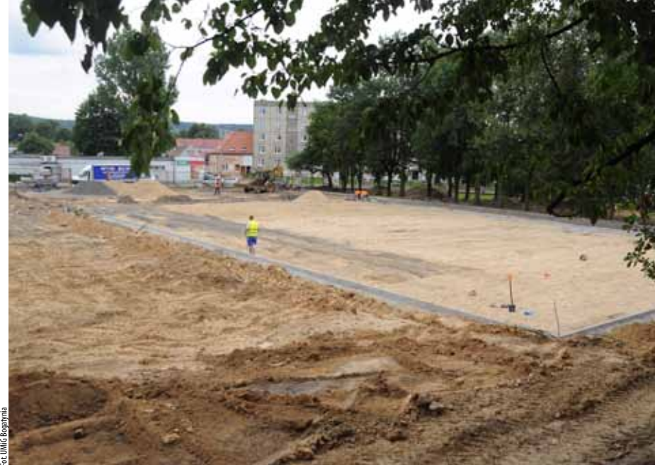
Prace przy budowie kompleksu boisk.
